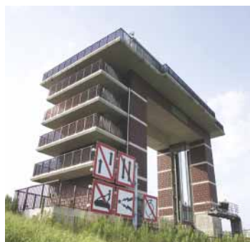
荒川ロックゲート
