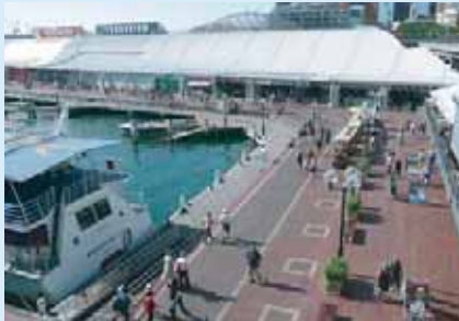
水上レクリエーション施設 (オーストラリア・シドニー)
