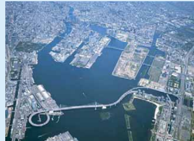
都市化が進む晴海、豊洲。超高層マンションの建設やオフィスビルの建設が今も進んでいます。
