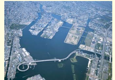
都市化が進む晴海、豊洲。超高層マンションの建設やオフィスビルの建設が今も進んでいます。
